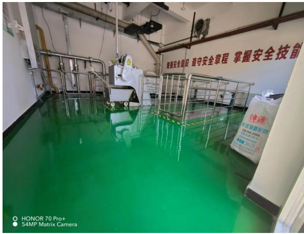
B 区污水处理站内部
