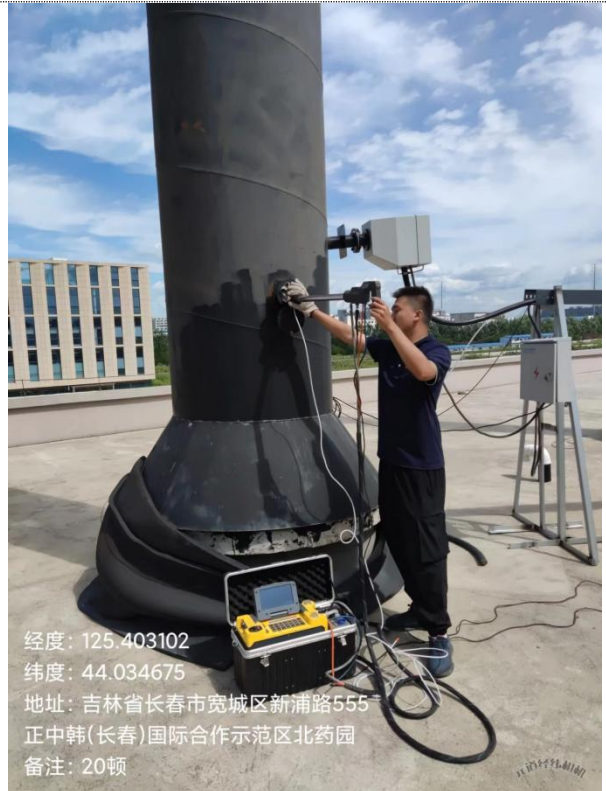
20吨锅炉废气采样
