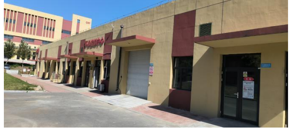
B 区污水处理站
