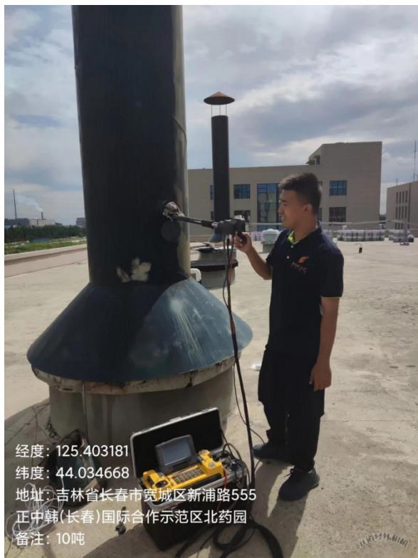
10吨锅炉废气采样
